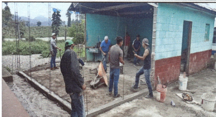
Foto1: Mejoramiento y seguimiento de muro para cocina.
