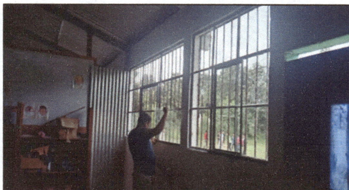
Foto 3: Elaboracion de 9 ventanas de estructura de metal con sus vidrios.
