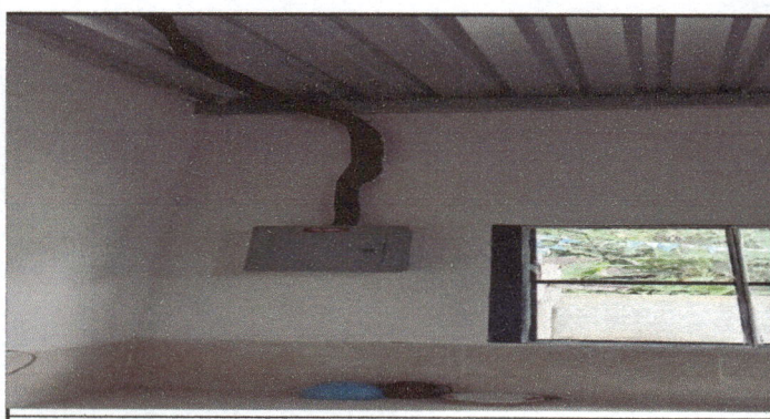
Foto 5: mantenimiento al sisema electrico.
