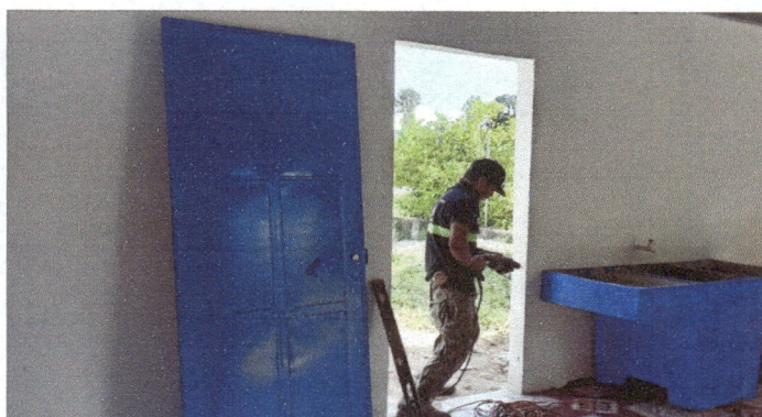
Foto 4: sustitución de 2 puertas de metal y una pila.
