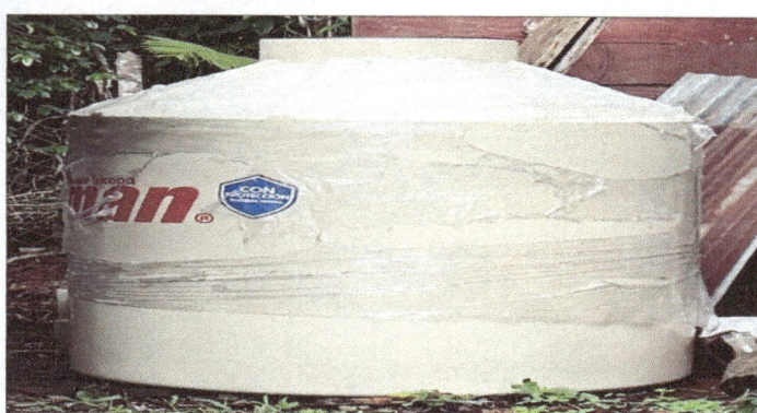
Foto 6: sustitución de deposito de agua tinaco para cocina.
