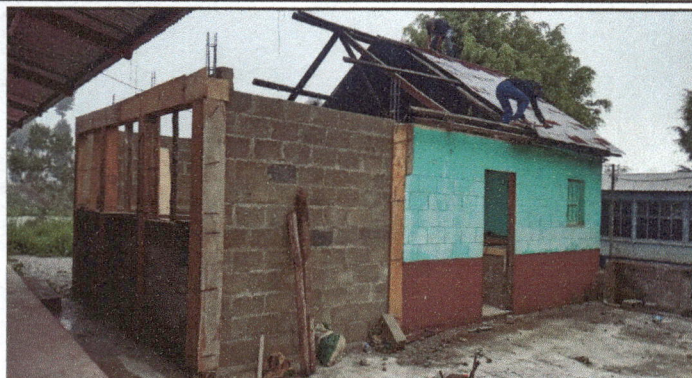
Foto 2: Mejoramiento de muro para cocina.
